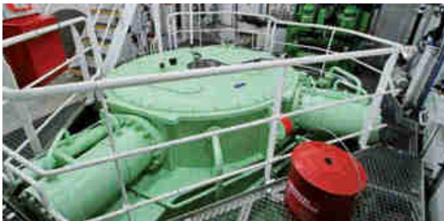
► Instalación en sala de máquinas de proa de uno de los propulsores Voith del remolcador.
