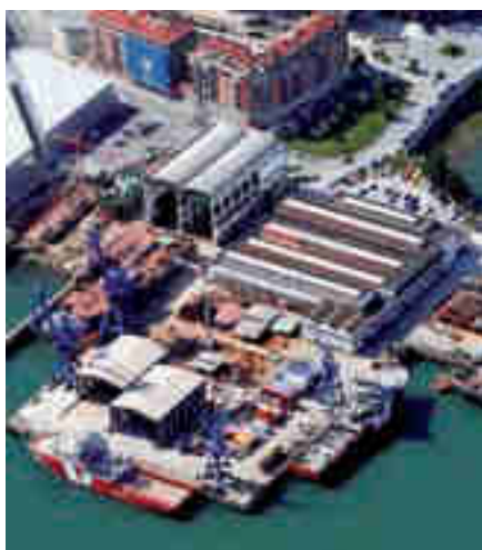
► Los astilleros de Zamakona en Pasaia (Guipúzcoa), donde se construirá la serie de remolcadores para Boluda en los próximos cinco años.
